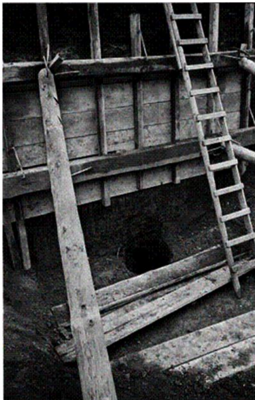
Doline beim Bau des Katharinen-Hospitals in Stuttgart, Jägerstraße
